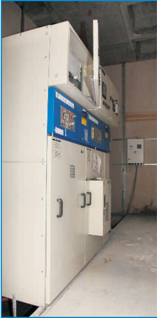
Metal, Clad O. G. Hücreleri
